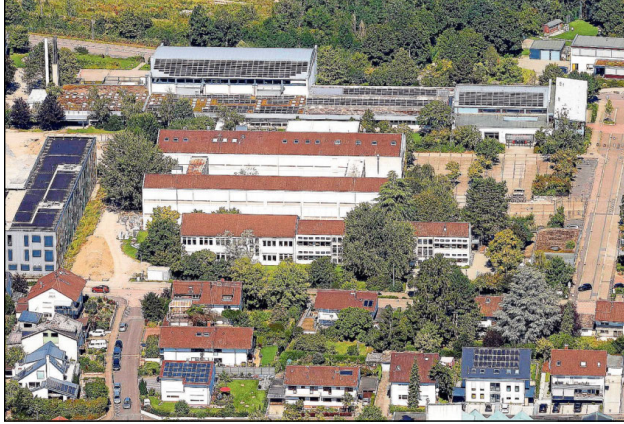
Das Ottheinrich-Gymnasium bildet einen Schwerpunkt der Wieslocher Investitionen in den kommenden Jahren. Über 17 Millionen könnte die Sanierung kosten. Das und weitere Maßnahmen sind nicht ohne neue Schulden möglich. Alle Fotos: Pfeifer
